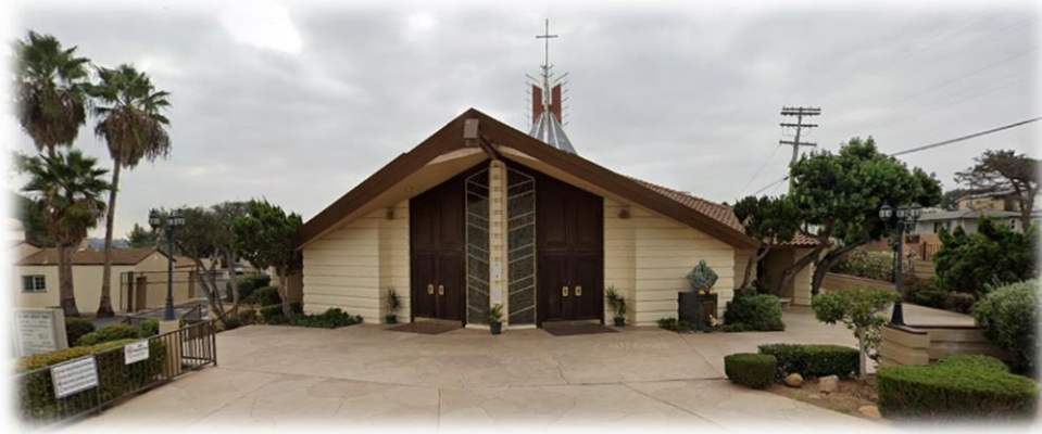
Nhà Thờ Thánh Gia
